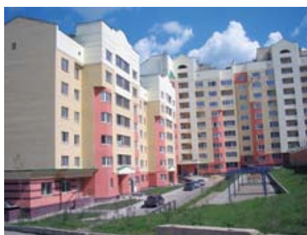
Фото 2. Каркасное 10-этажное здание с кирпичными трехслойными теплоэффективными стенами.
