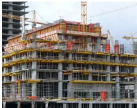
Балочно-ригельная опалубка PSK-Classic и опалубка перекрытий PSK-Cup на строительной площадке «Москва-Сити».
